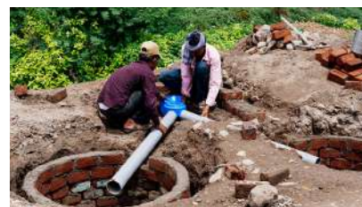
Installing V-Trap toilet
